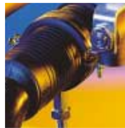
Schalldämmte WT-Abflußleitung
