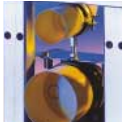
Schalldämmung am WC Zu- und Ablauf
