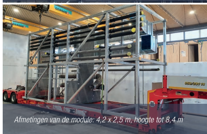
De modules werden met een kraan via de bouwputten in het gebouw getakeld.
