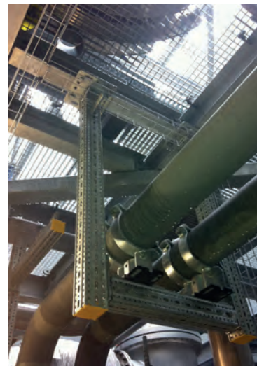
Archieffoto: Modulair montagesysteem siFramo voor de snelle montage van secundaire staalconstructies
